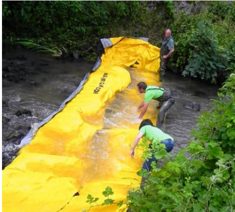
Le Water-Gate, en démonstration dans la Zinsel : un barrage mobile qui permet, dans ce cas, d'augmenter le niveau du cours d'eau pour que les pompiers puissent la pomper pour éteindre un incendie. PHOTO DNA
