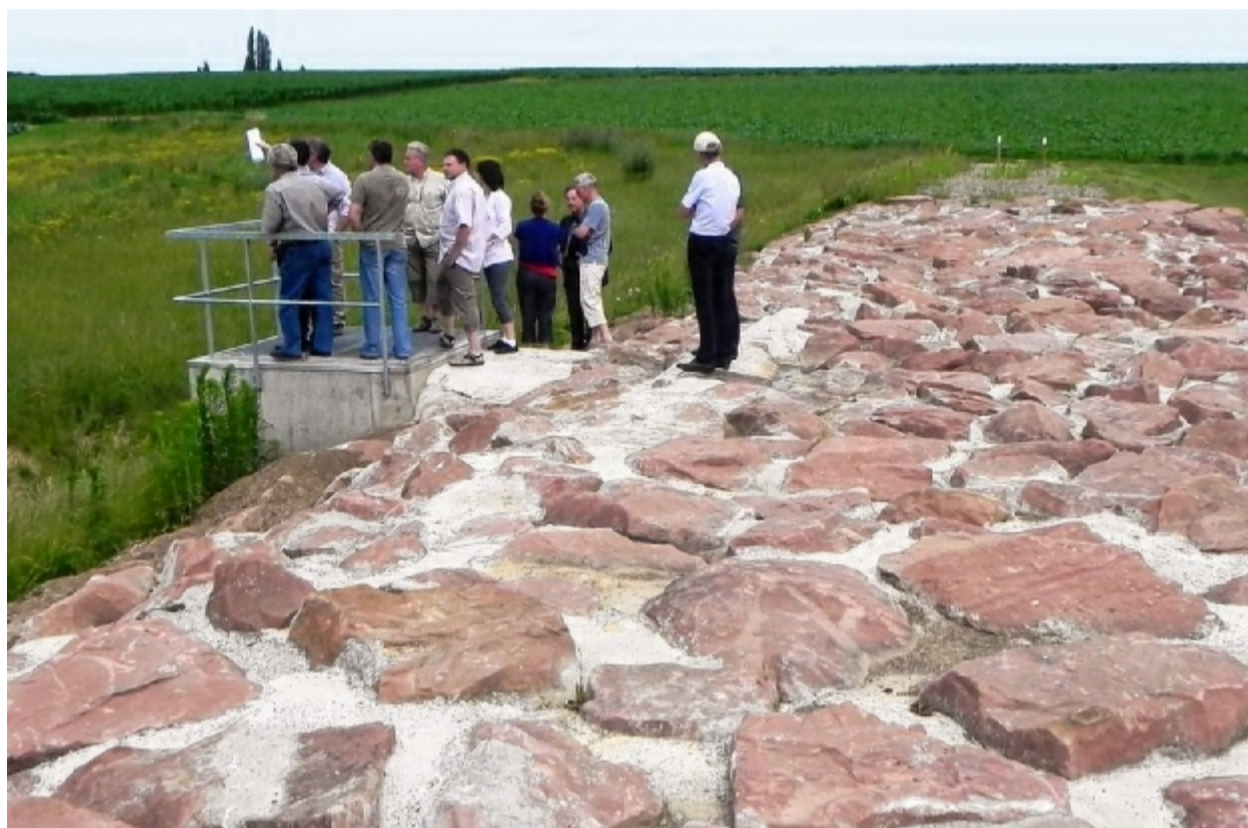
À Alteckendorf, visite d'un ouvrage de rétention d'eau recouvert de blocs de grès des Vosges. PHOTO DNA
